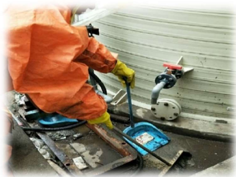
泄漏小组成员清扫沙土
